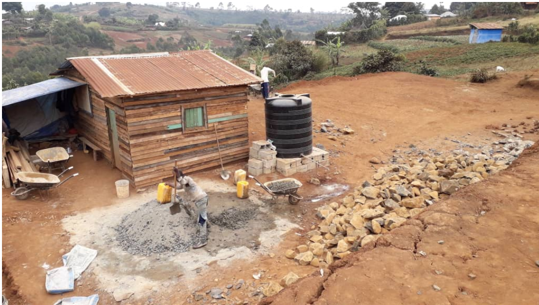
Abbildung 64: Bauhütte mit Baumaterial auf dem Hanggelände (Juli 2018)
