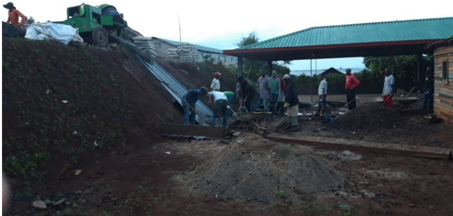
Abbildung 70: Erstmaliger Einsatz eines Betonmischers für den Estrich
