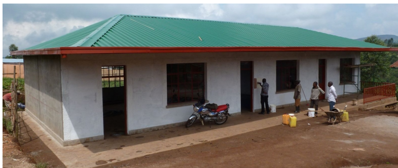
Abbildung 21: Juni 2016: Außenanstrich, Dach fertig
