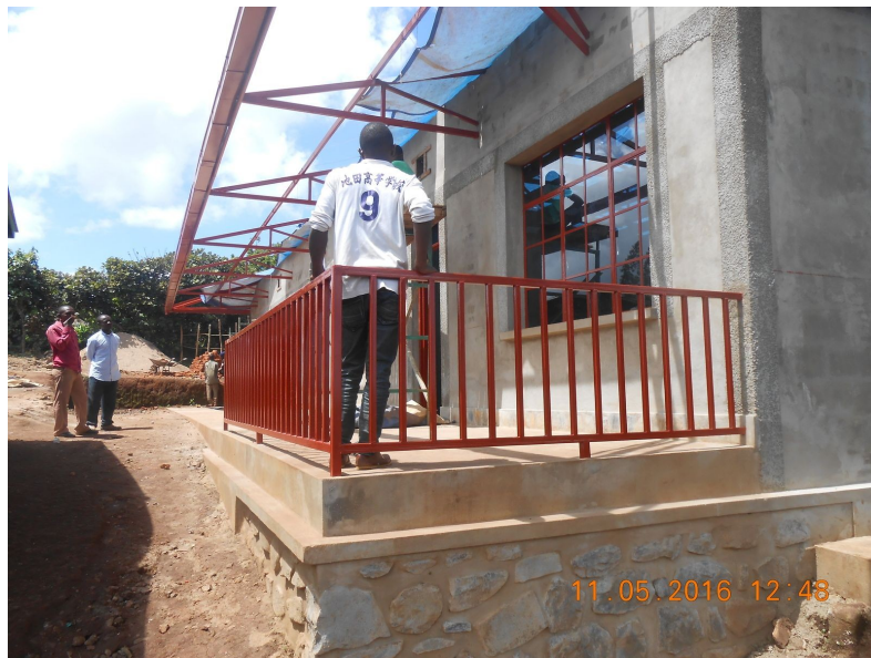
Abbildung 18: Mai 2016: Balustrade zur Straße
