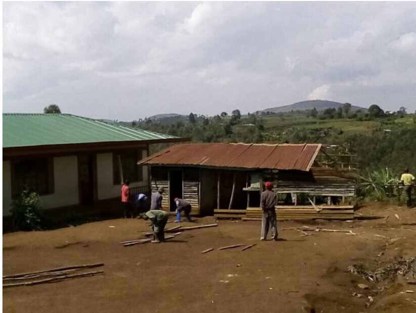
Abbildung 26: Abriss der Altbauten (November 2017)
