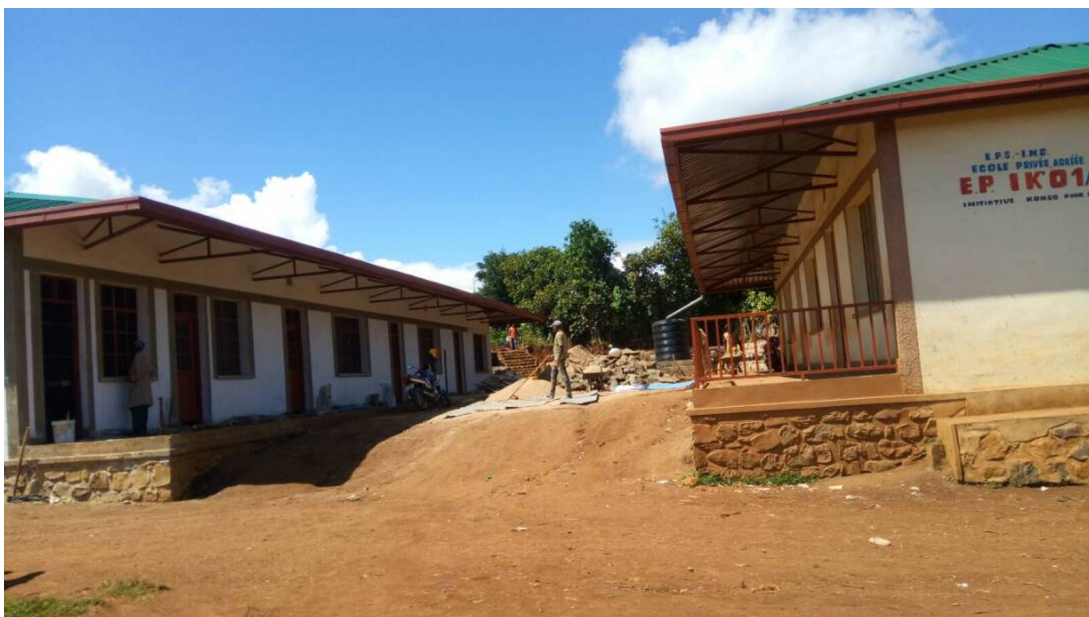
Abbildung 41: Anstrich des Erweiterungsbaus (Mai 2018)
