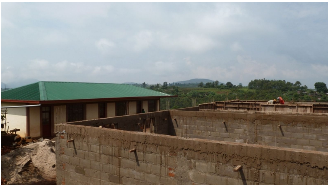
Abbildung 35: Dachfundamente (Februar 2018)
