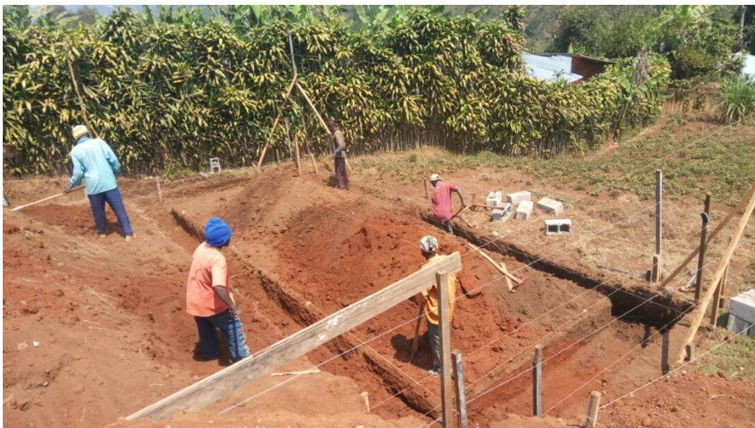
Abbildung 65: Fundament von Zisterne/Toiletten (Juli 2018)
