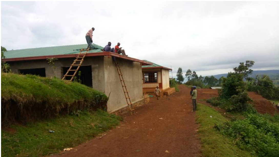
Abbildung 40: Blick von der Straße zum Hanggelände und auf beide Schulbauten (Mai 2018)
