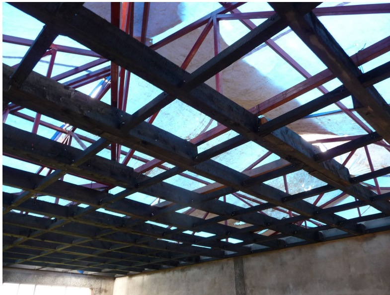
Abbildung 16: April 2016: Holzkonstruktion für die Innendecken
