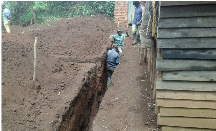
Abbildung 27: Ausschachtung für den zweiten Bau (Dezember 2017)
