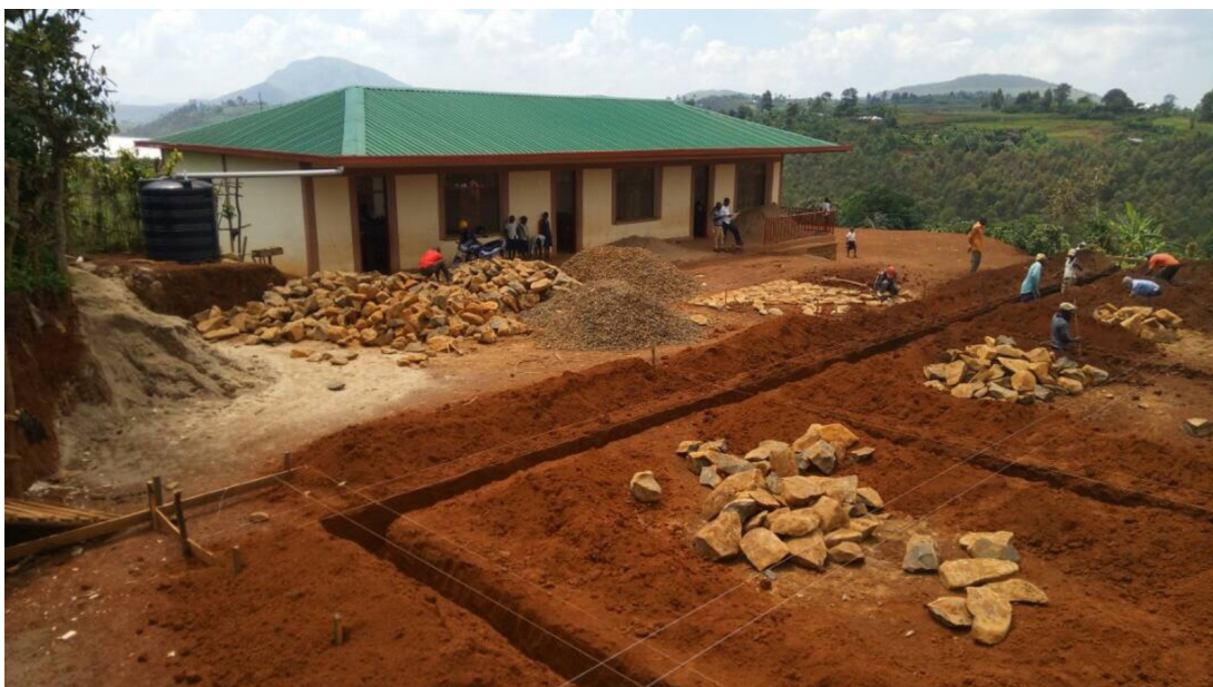
Abbildung 31: Baumaterial für Grundmauern (Januar 2018)
