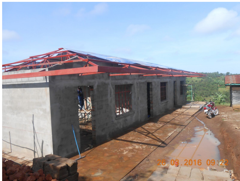
Abbildung 14: März 2016: Weiterbau des Dachs
