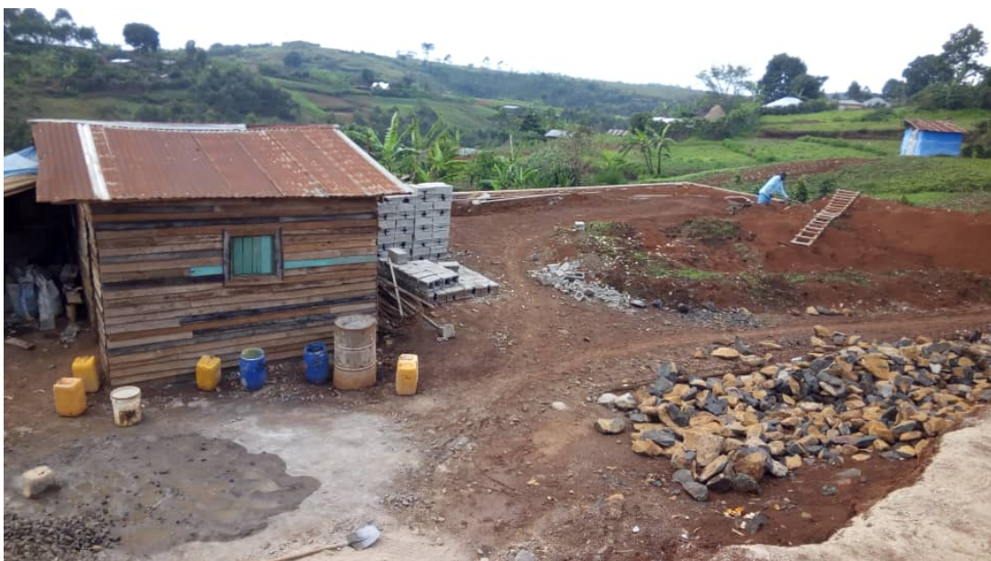
Abbildung 53: Die Bauhütte auf dem Pausenhofgelände mit Stützmauer (November 2018)
