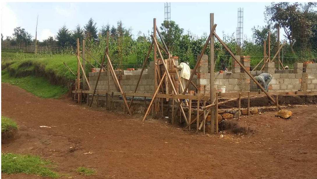
Abbildung 33: Stützmauer zur Straße (Januar 2018)
