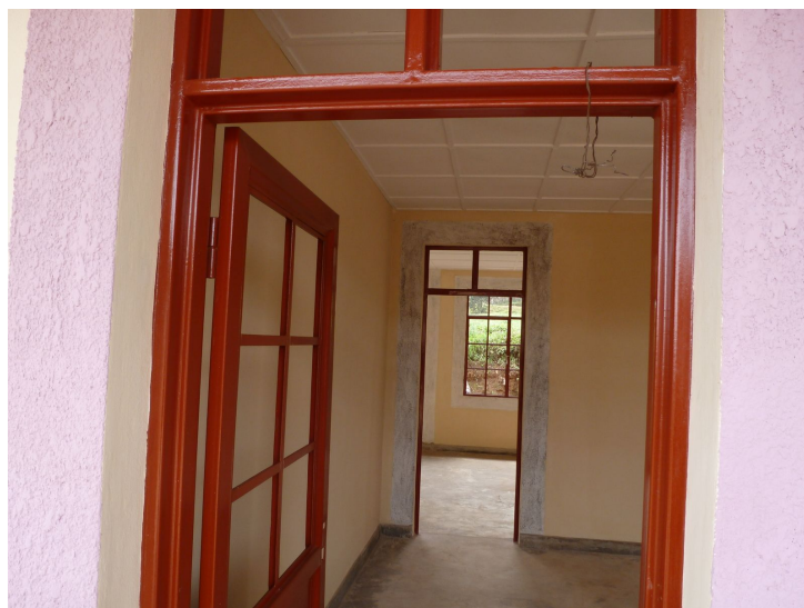
Abbildung 42: Innenanstrich Verwaltungsräume (Juni 2018)
