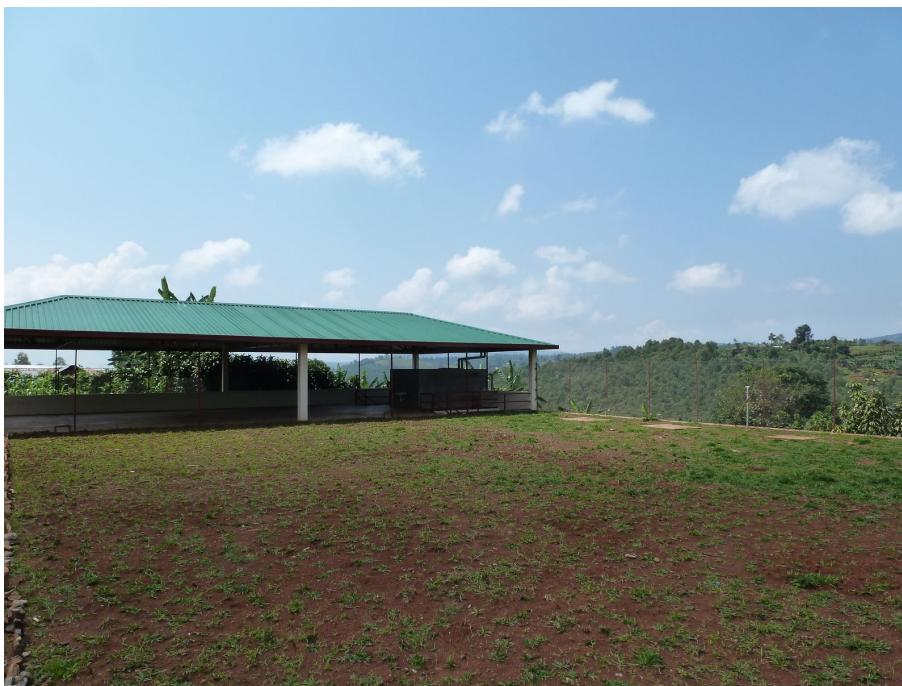
Abbildung 71: Das fertige Freidach mit Toiletten/Zisterne, vorne Pausenhof/Sportplatz
