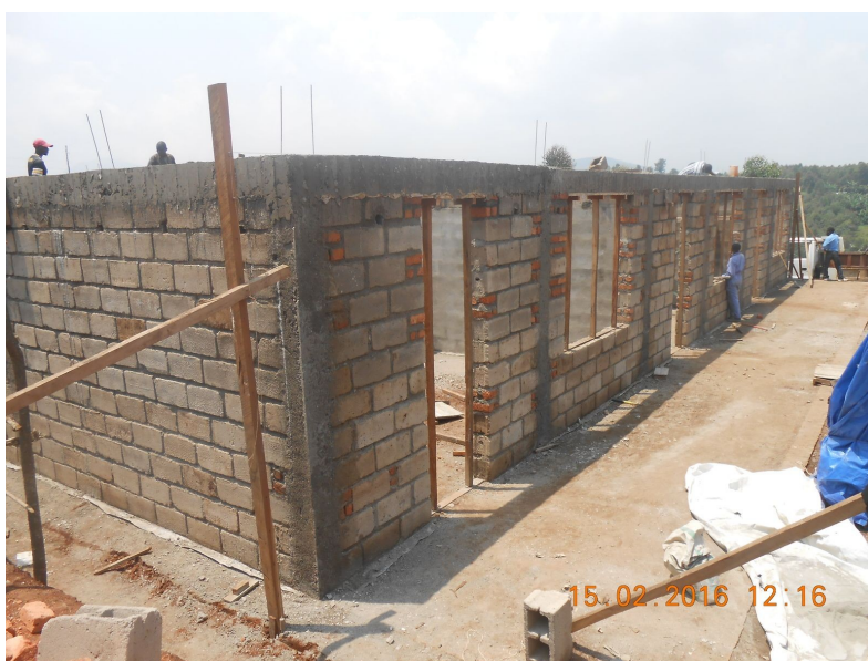
Abbildung 11: Mitte Februar 2016: Betonträger, Verputzarbeiten
