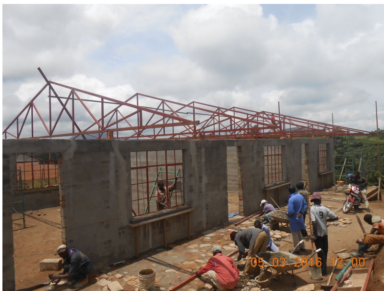
Abbildung 13: März 2016: Leichtdach-Konstruktion, Vorplatz
