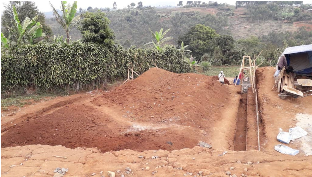
Abbildung 66: Fundament des überdachten Freiplatzes (Juli 2018)
