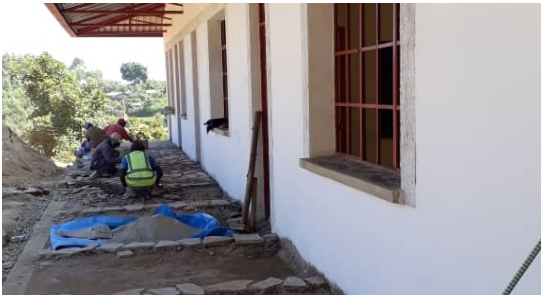
Abbildung 47: Restliche Plattenarbeiten ... (August 2018)
