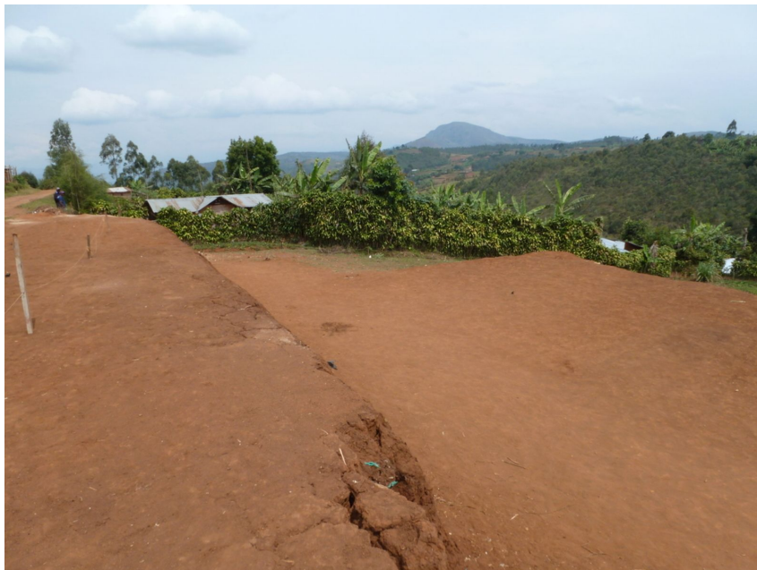
Abbildung 61: Planierung mit dem Aushub des Erweiterungsbaus
