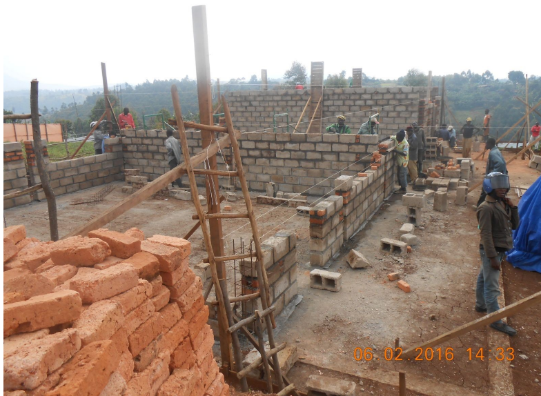
Abbildung 10: Anfang Februar 2016: Bau aller Mauern
