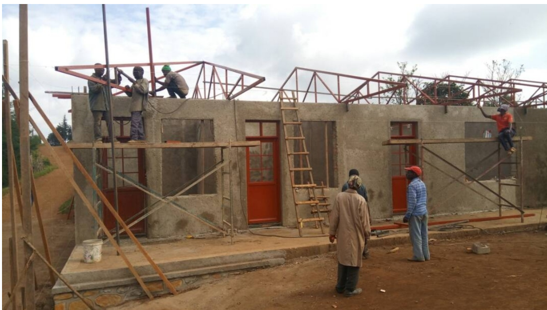
Abbildung 37: Einbau der Türen (Februar 2018)
