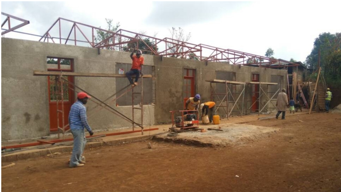
Abbildung 36: Aufbringen der Leichtdach-Elemente (Februar 2018)
