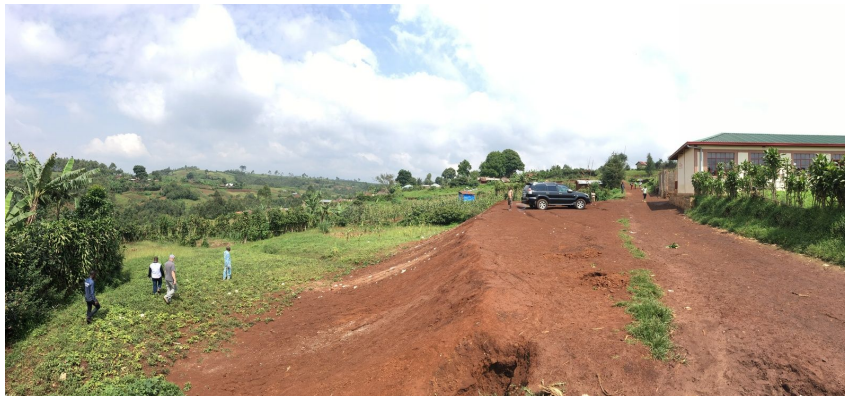
Abbildung 60: Gelände vor der Planierung
