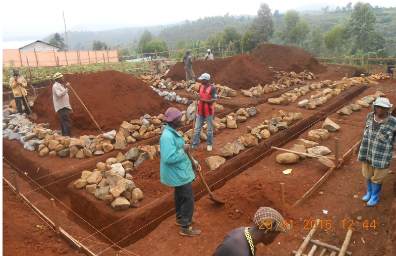
Abbildung 8: Januar 2016: Anlieferung Fundamentsteine, Fundament
