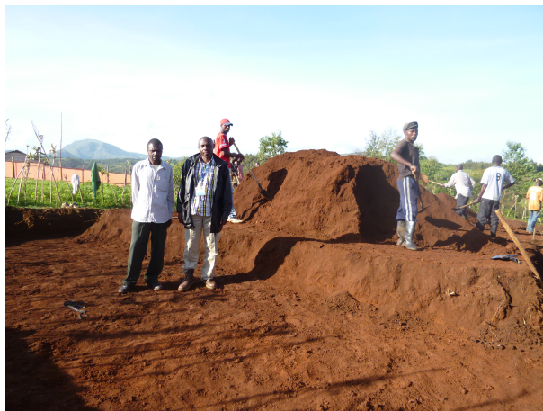
Abbildung 7: Anfang Dezember 2015: Beginn der Erdarbeiten
