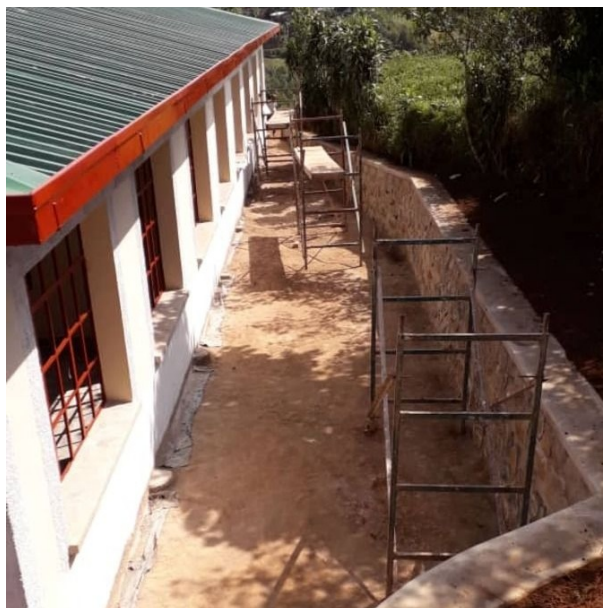
Abbildung 51: Stützmauer hinter dem Erweiterungsbau (August 2018)
