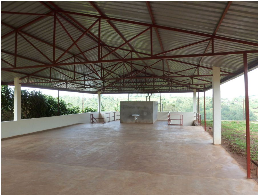
Abbildung 72: Die regengeschützte Halle nach Fertigstellung
