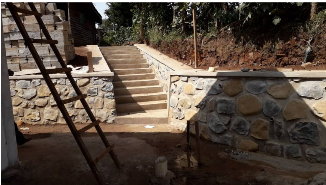
Abbildung 45: Neue Treppe zum Gartenbereich (Juli 2018)
