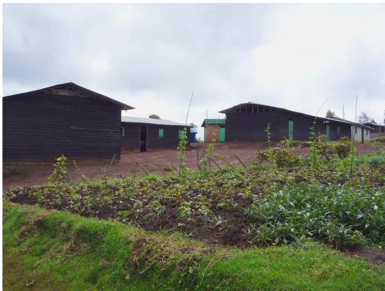
Abbildung 5: 1/2009: Die Schulbauten in Holz mit „Toilette“
