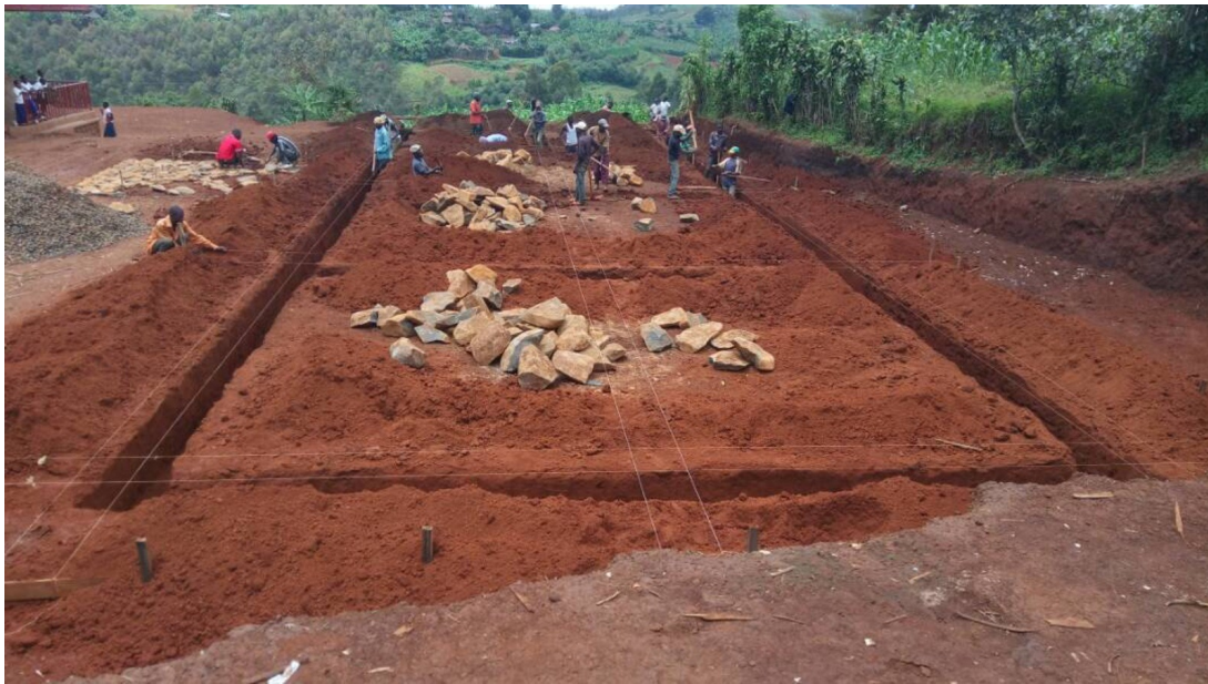
Abbildung 30: Aushub Grundmauern (Januar 2018)
