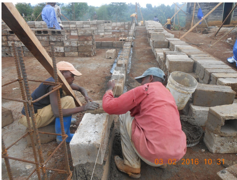
Abbildung 9: Januar 2016: Anlieferung von Ziegeln, Grundmauern
