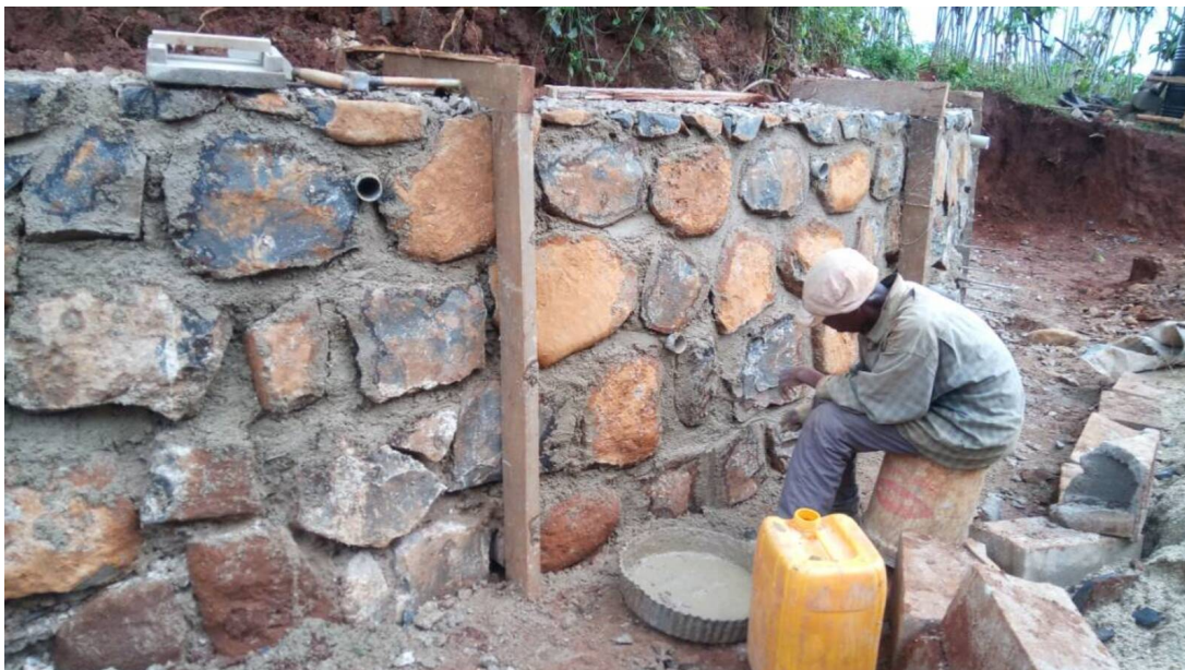
Abbildung 44: Zyklopenmauer im Pausenhofbereich an der Zisterne (Juli 2018)
